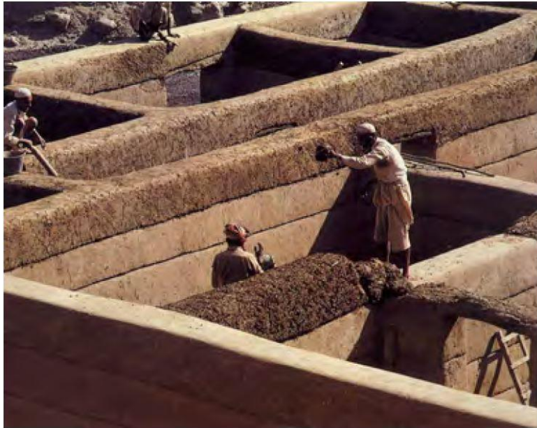
صورة 7: توضح بناء جدران الزُّابُور بدون استخدام القالب الخشبي.
