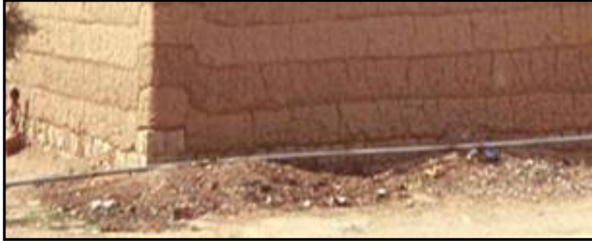
صورة6: توضح رفع بناء أركان المبنى عن مستوى المدماك بمقدار ارتفاع مدماك الطين.
